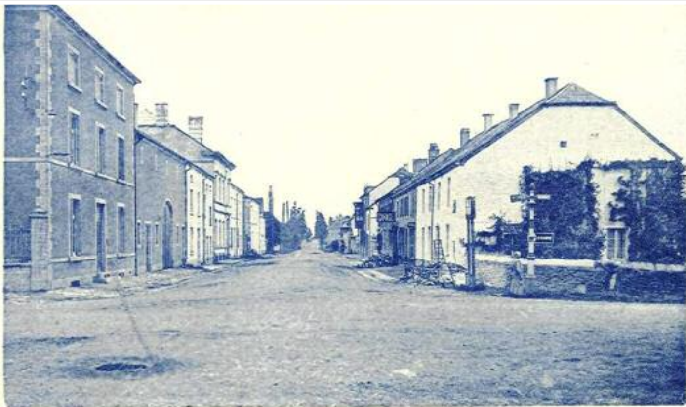
Habay-la-Neuve, Rue de la Station
