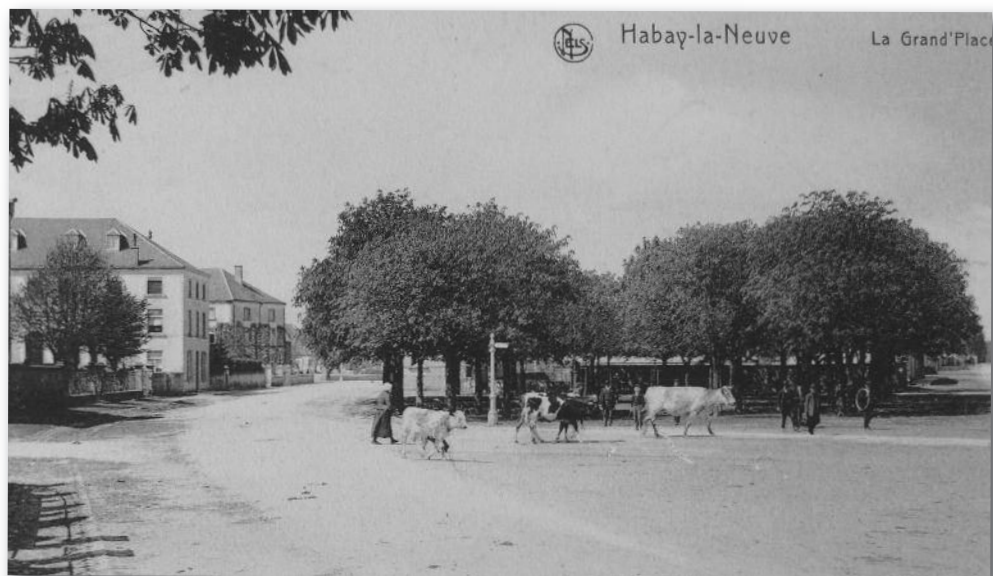
Vue de la Place traversée par du bétail
