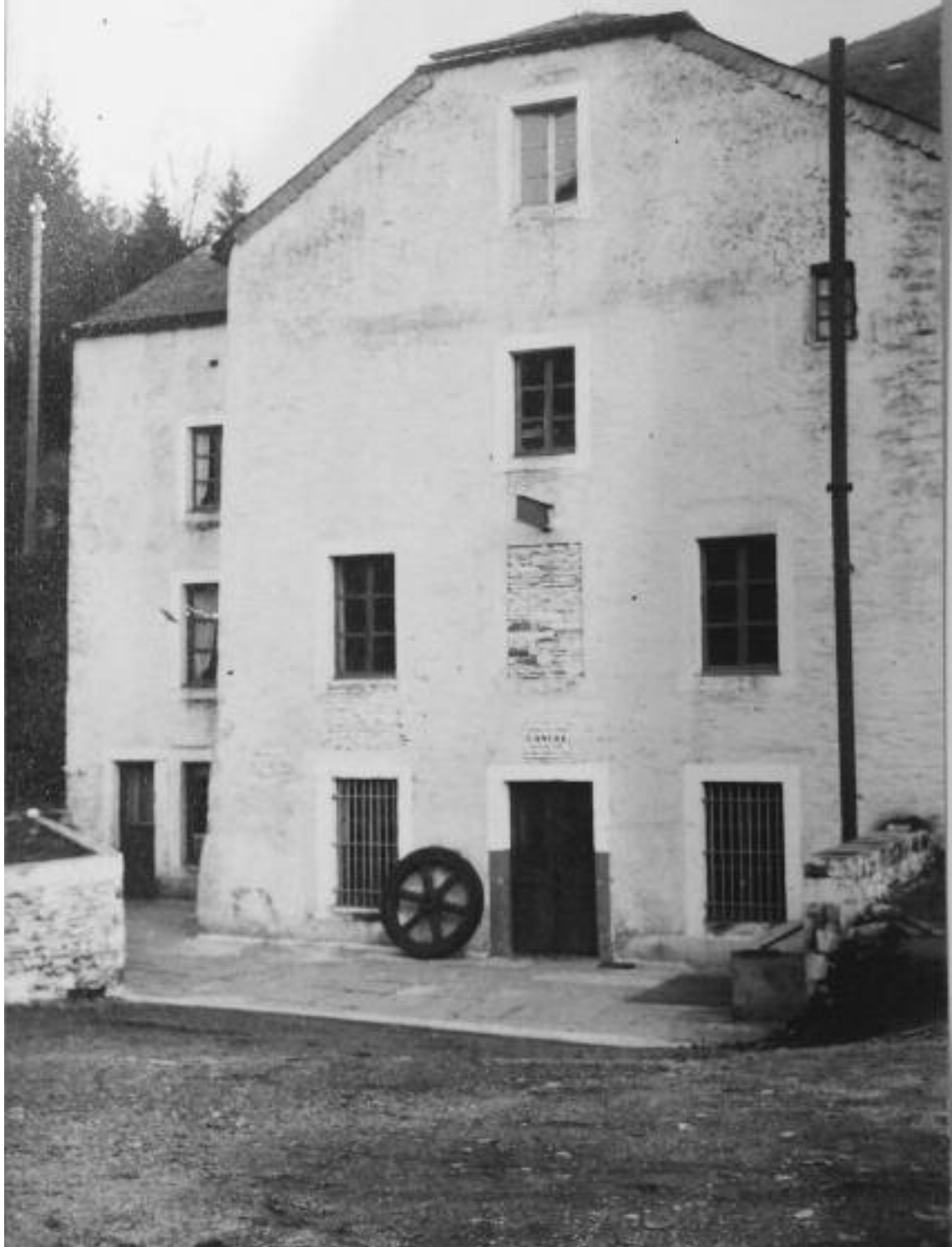
Vue agrandie de l'arrière de l'ancienne centrale électrique de Bologne détruite le 10 mai 1940
