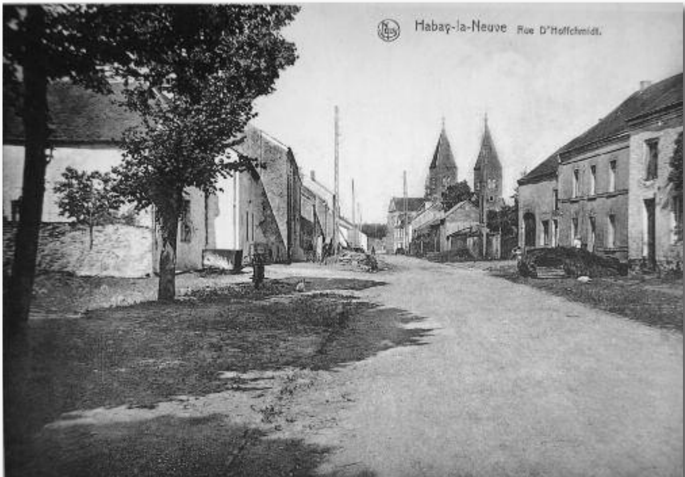
Deux vues de la rue d'Hoffschmidt, sur la plus ancienne ci-dessus, on voit parfaitement l'ancienne installation électrique où les lignes couraient directement le long des façades. Ci-dessus la même rue avant guerre 40, les poteaux en béton installés par la firme Muller assurent la liaison avec l'électricité domestique.
