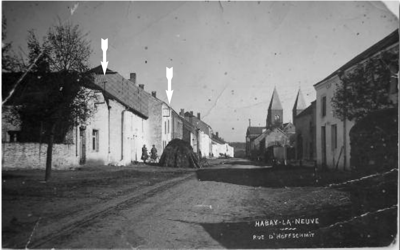
Deux vues de la rue d'Hoffschmidt, sur la plus ancienne ci-dessus, on voit parfaitement l'ancienne installation électrique où les lignes couraient directement le long des façades. Ci-dessus la même rue avant guerre 40, les poteaux en béton installés par la firme Muller assurent la liaison avec l'électricité domestique.
